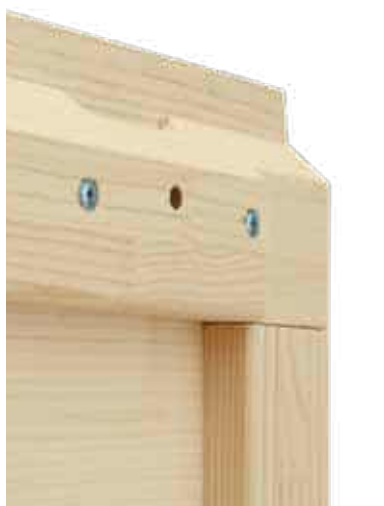
Verstärkung an den Lamellenenden
